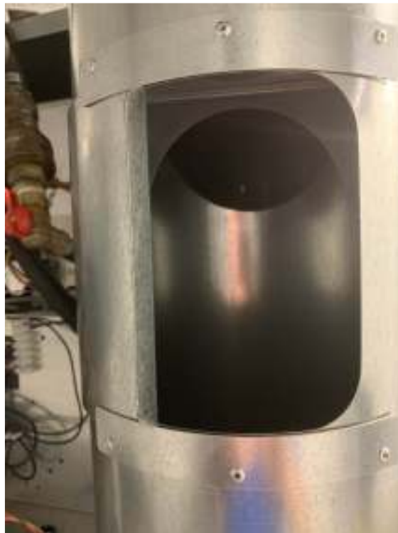
Ouverture pour un nettoyage de routine
