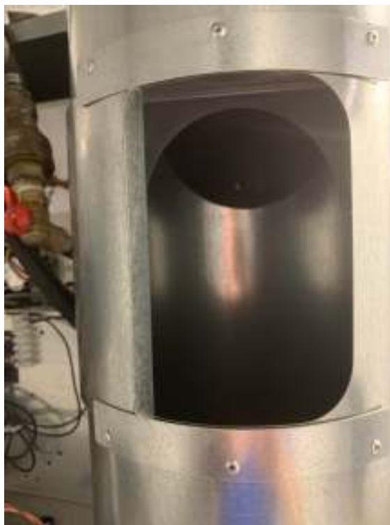
Ouverture pour un nettoyage de routine
